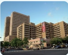
附設中和紀念醫院 Chung-Ho Memorial Hospital
